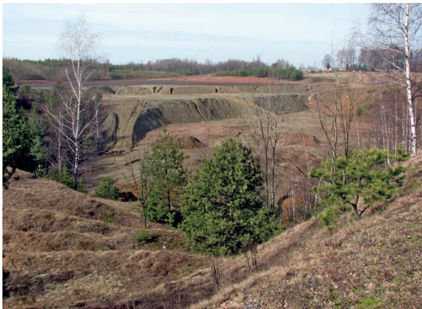
Fig. 21. An open-cast mine of Zn-Pb ores in Bolesław during reclamation (phot. Paweł Kapusta) Ryc. 21. Wyrobisko rudy Zn-Pb w Bolesławiu w trakcie rekultywacji (fot. Paweł Kapusta)
